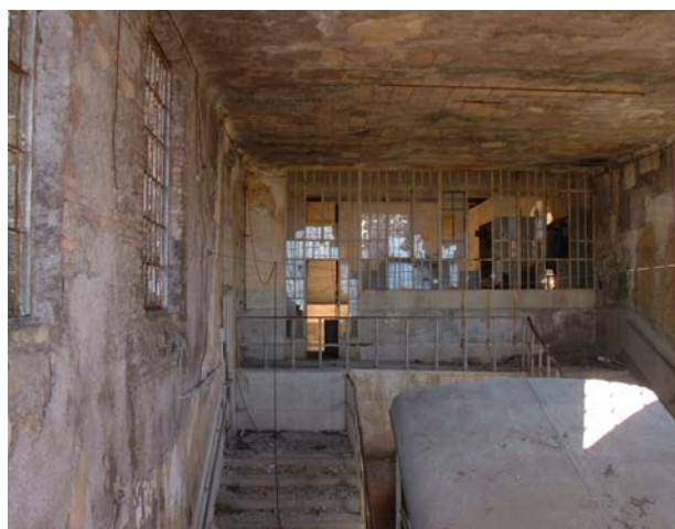
Stazione di monte - Interno
