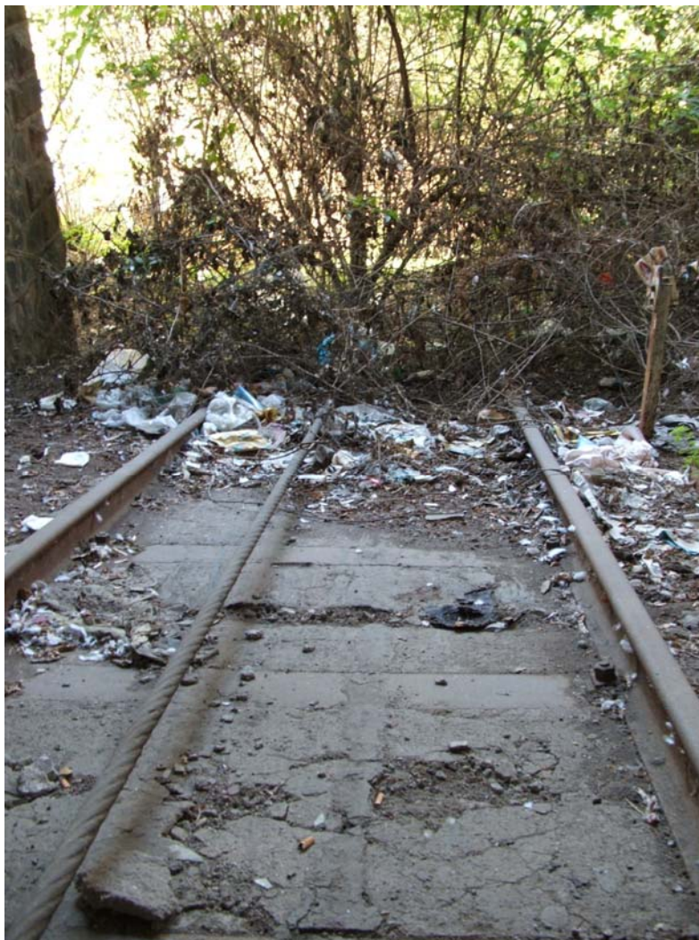
Stato attuale dei binari della funicolare presso la stazione di monte
