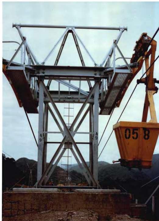
Sostegno di Rio Branco con rulli “bassi”
