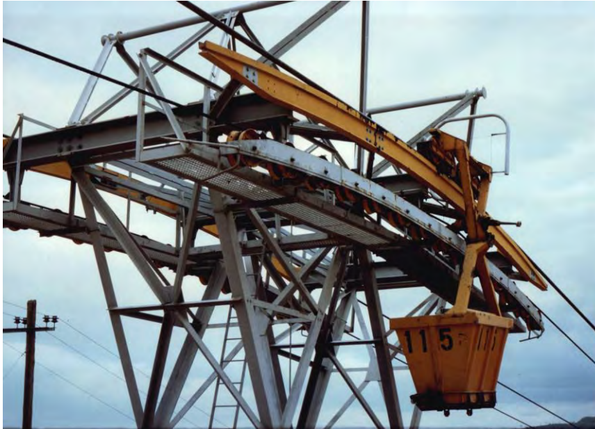
Sostegno di Rio Branco con scarpa fissa e rulliera di tipo “alto”
