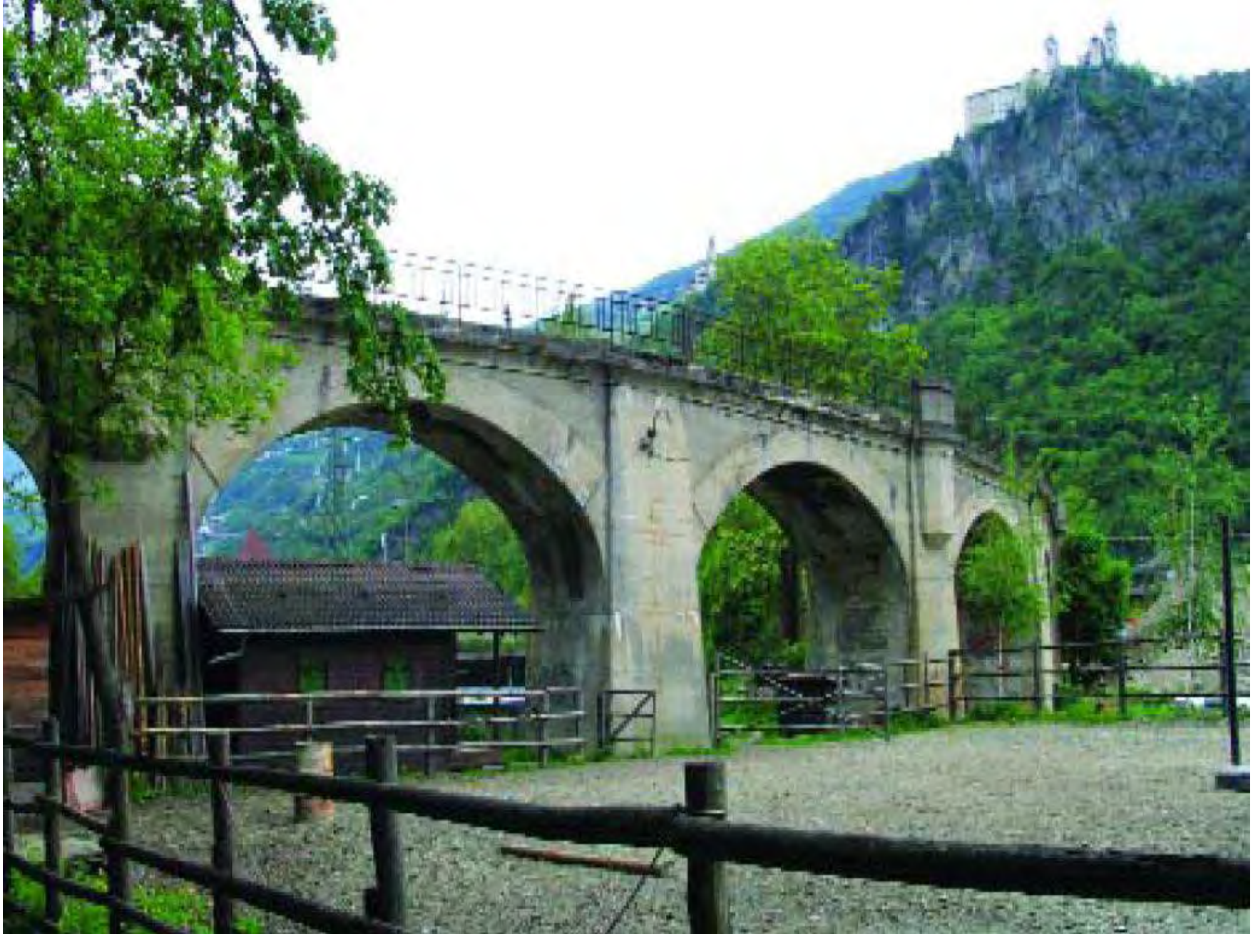
Viadukt Grödnerbahn, 1916, von 6.000 russischen Kriegsgefangenen im 1. Weltkrieg erbaut, um die Dolomitenfront mit Nachschub zu versorgen
