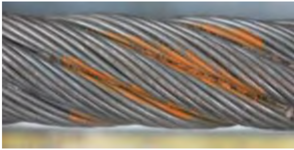
Photo 4.21: Corrosion dans des gorges de toron
