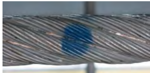
Photo 4.5 : Impact de foudre 1,5 x diamètre du toron
