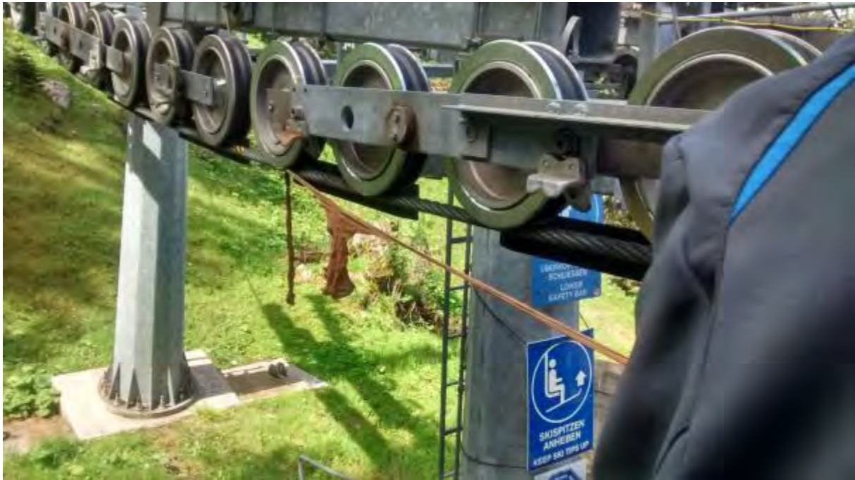
Photo 5.19: Collant coincé sous les galets qui reste pendu au câble
