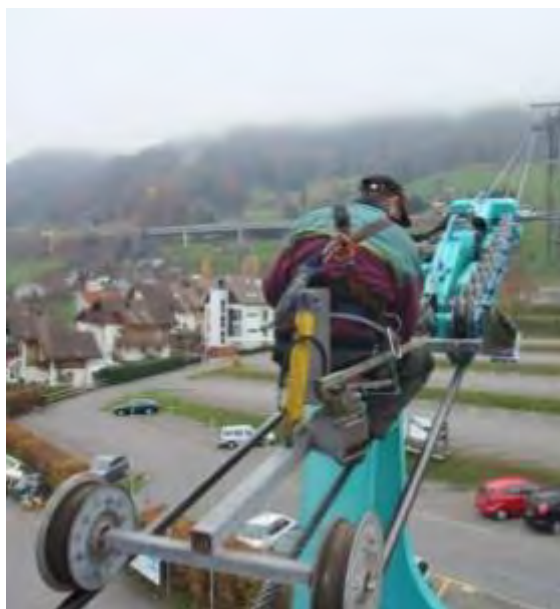
Photo 3.11 : Examen visuel de câbles porteurs avec dispositif pour s'asseoir
