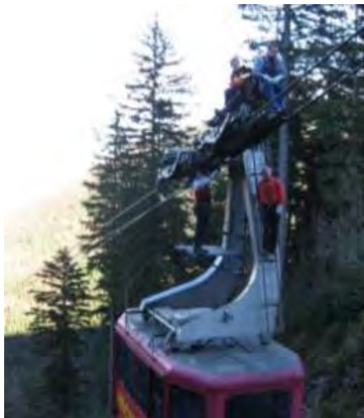
Photo 3.8 : Examen visuel de câbles porteurs sur une échelle, une plateforme, un siège et le chariot
