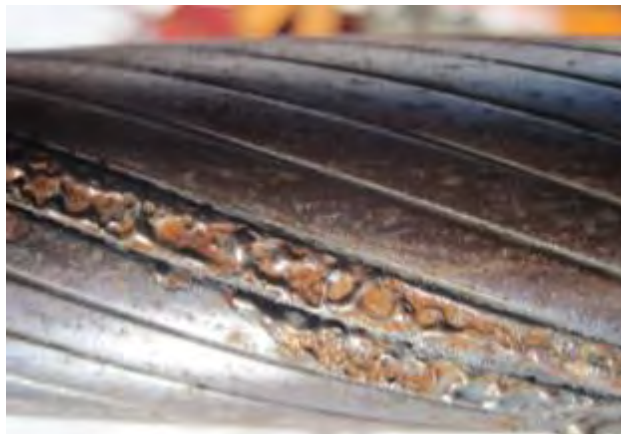
Photo 2.11 : Défaut causé par la foudre sur un câble clos
