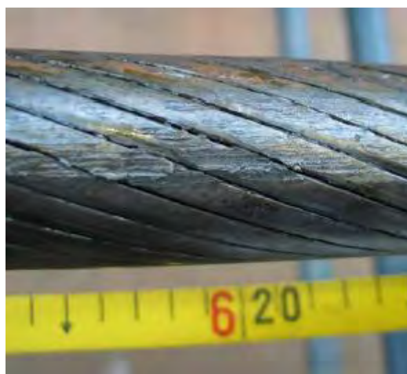
Photo 2.9 : Défaut sur câble porteur - vue détaillée [6]
