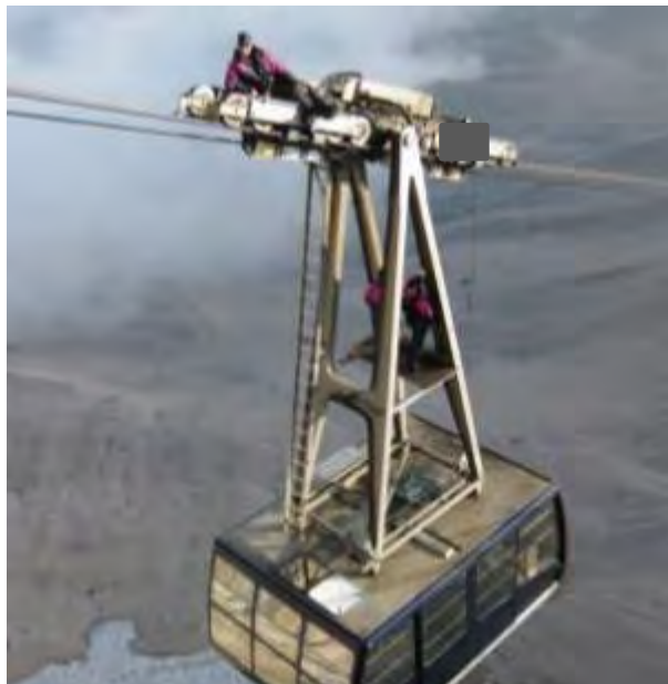
Photo 3.9 : Examen visuel de câbles porteurs sur une plateforme et le chariot
