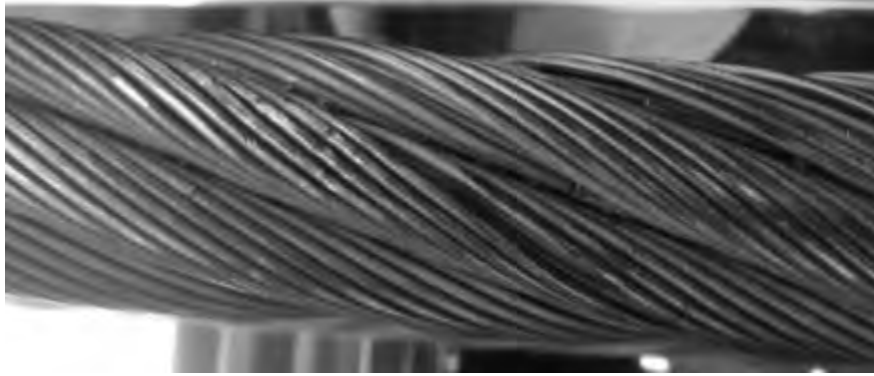
Photo 5.25 : Dommages à détecter lors de l'examen
