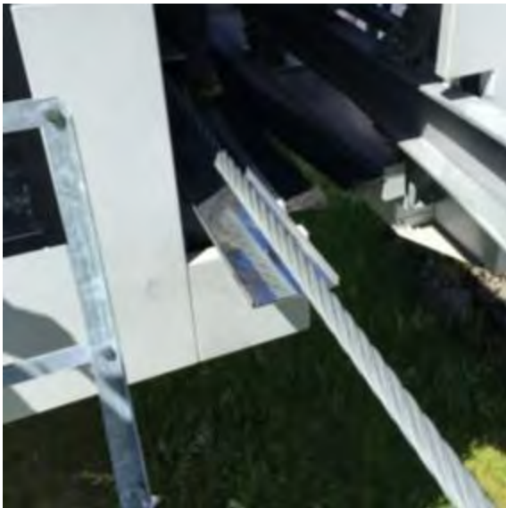
Photo 3.12 : Miroir sur une station modulaire standardisée pour téléphériques monocâbles à mouvement continu (vue de l'extérieur de la station)
