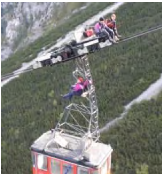
Photo 3.10 : Examen visuel de câbles porteurs avec dispositif pour s'asseoir ou s'allonger
