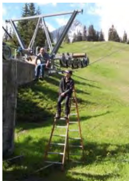
Photo 3.2 : Examen visuel sur une échelle et une petite plateforme
