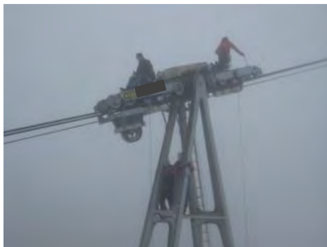
Photo 3.3 : Brouillard lors d'un examen de câble porteur
