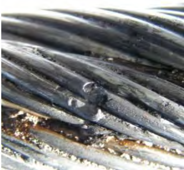
Photo 2.4 : Dommage causé par la circulation du courant
