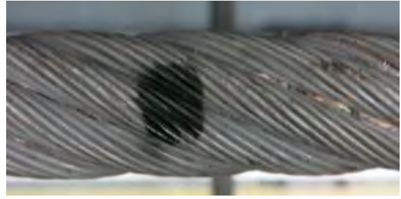
Photo 4.16 : Rupture de fils métalliques 1,5 x diamètre du toron
