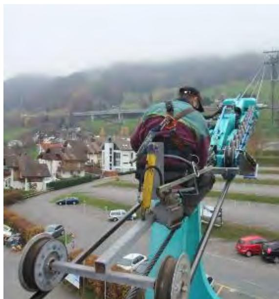
*Figura 3-11: Inspección visual en cable carril utilizando un asiento especial*
