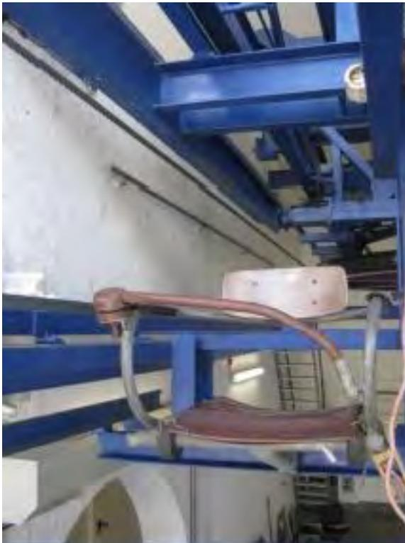
*Figura 3-4: Asiento especial para inspecciones*
