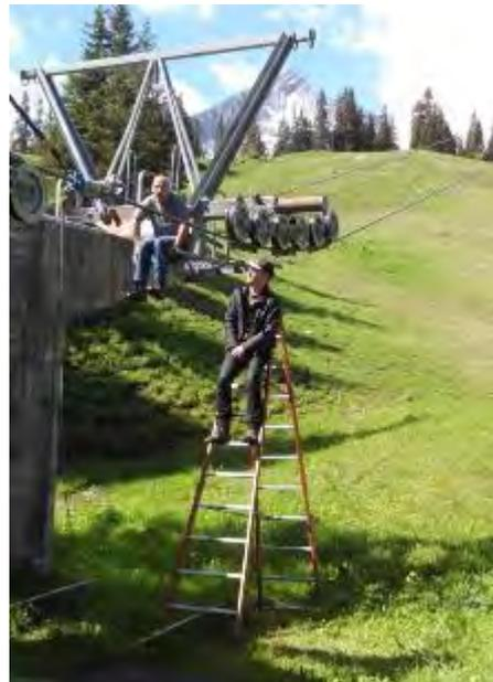
*Figura 3-2: Inspección visual sobre una escalera y una pequeña plataforma*
