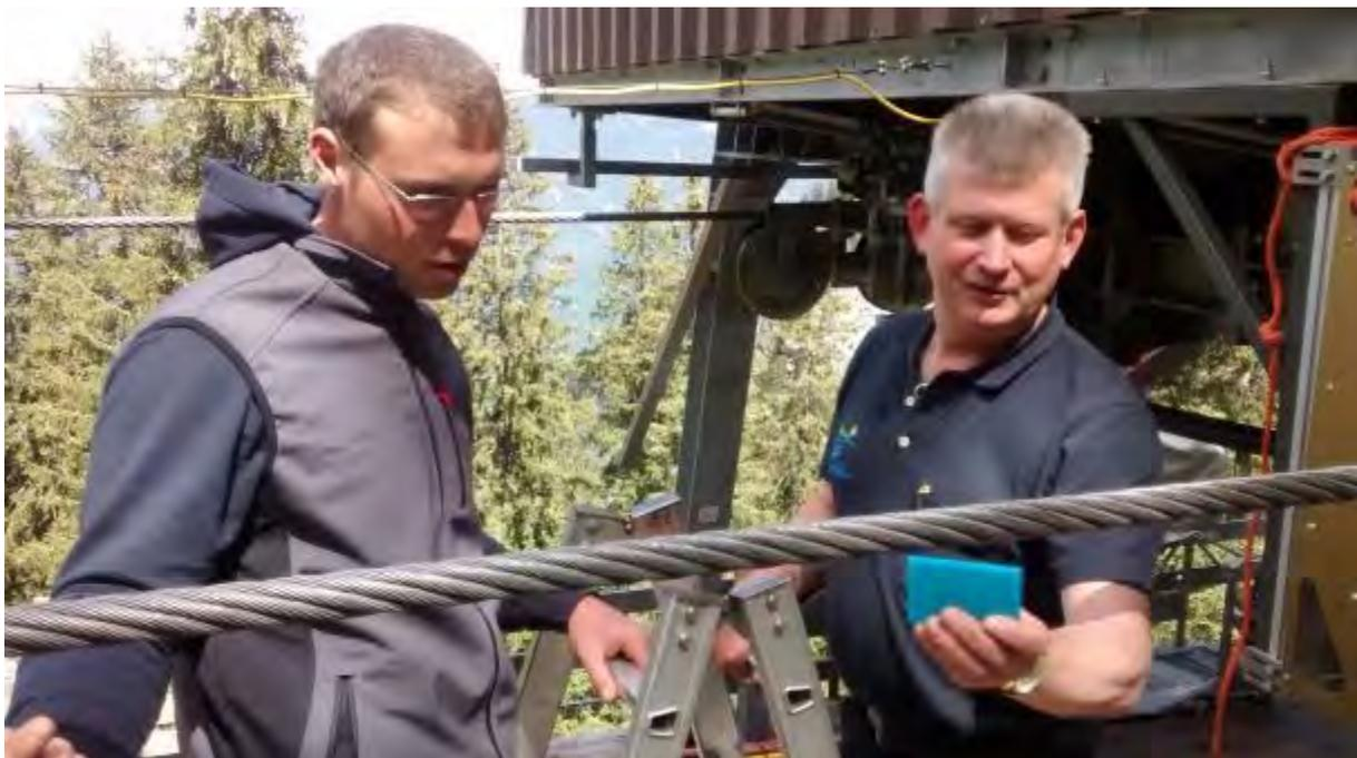
*Figura 5-22: Inspección utilizando espejo de mano*
