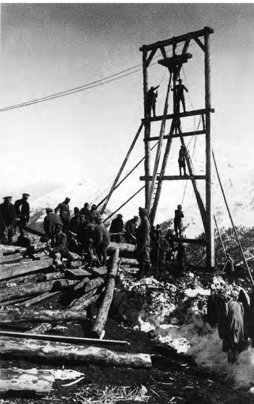
**Kriegsmaterial wird mittels Seilbahnen an die Dolomitenfront befördert, bis zu 250 T am Tag. Plan im hintersten Grödental war Ausgangspunkt eines weit verzweigten Seilbahnnetzes. Seilbahnfabrikant Luis Zuegg konnte als Landsturvingenieur beweisen, dass seine Theorien zur strafferen Seilspannung geringere Baukosten und höhere Fahrgeschwindigkeit ermöglichten.**
