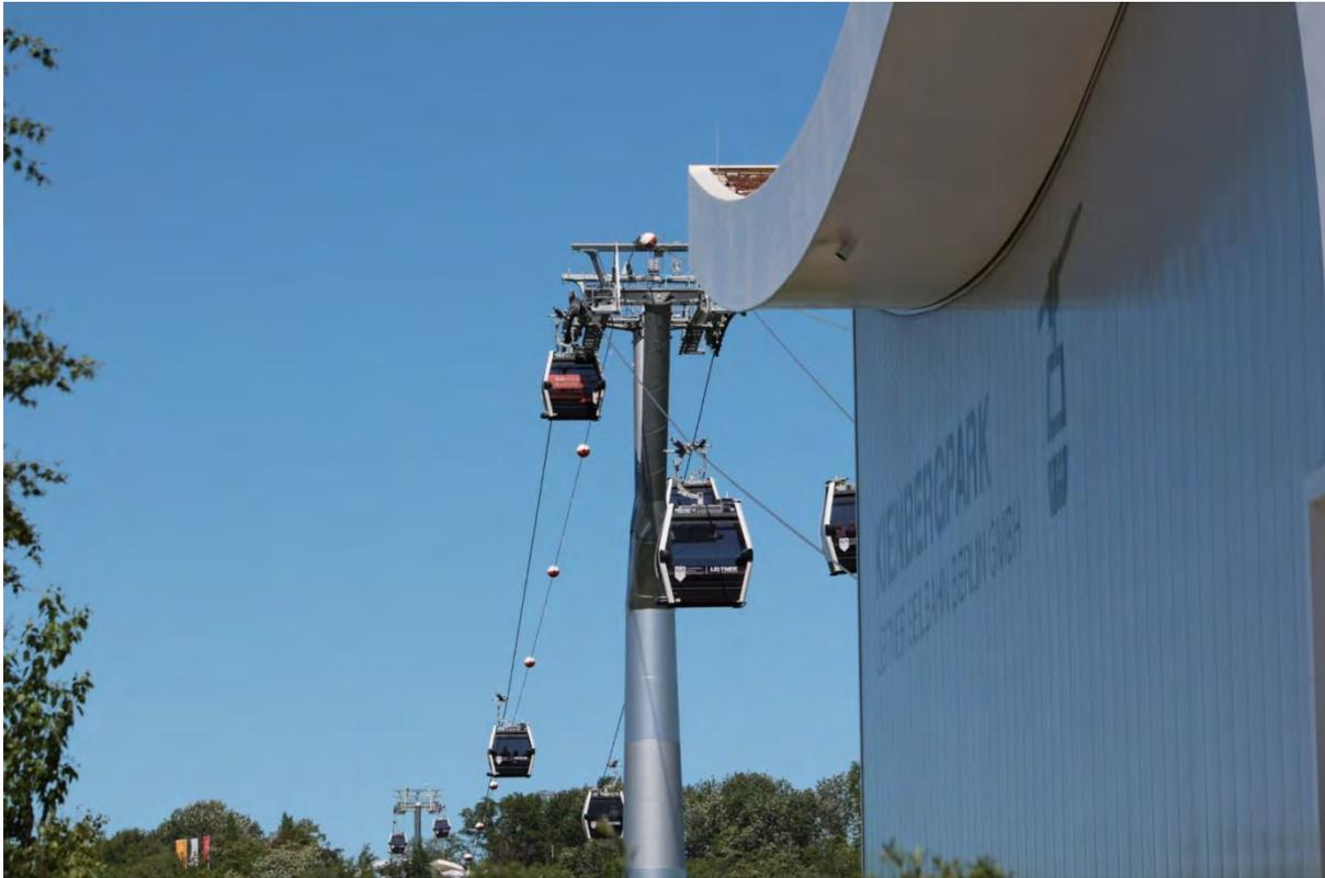
Vorteil: **wenige Stützen**, daher geringe Kosten, lange Spannfelder, daher gut zum „Überbrücken“, minimaler Platzbedarf, **Fahrweg fast unsichtbar!**
