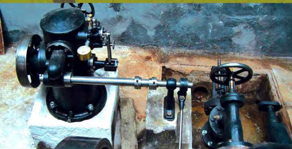
Centrale Idroelettrica Sacco - Schaukraftwerk Sachsenklemme
