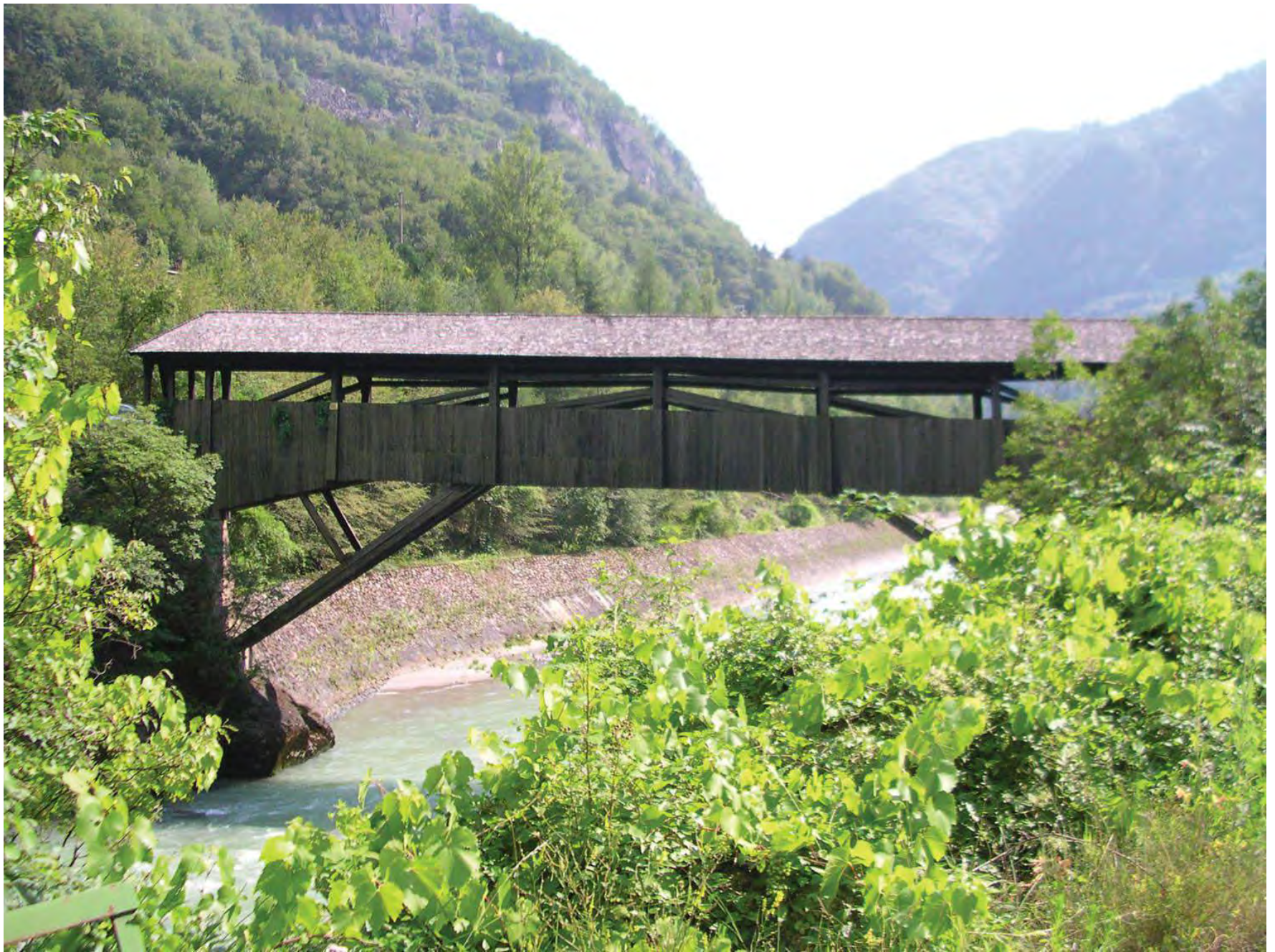
Kastelruther Haltestelle mit Holzbrücke, 1898, letzter erhaltener Kleinbahnhof der Brennerbahn
