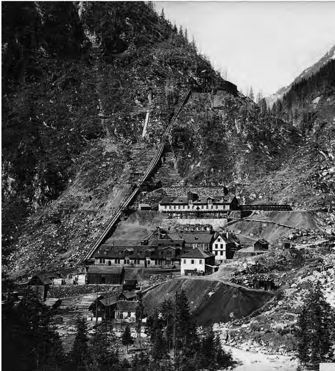
Wassertonnenaufzug am Schneeberg, 22km Schienenwege am höchstgelegenen Bergwerk Europas
