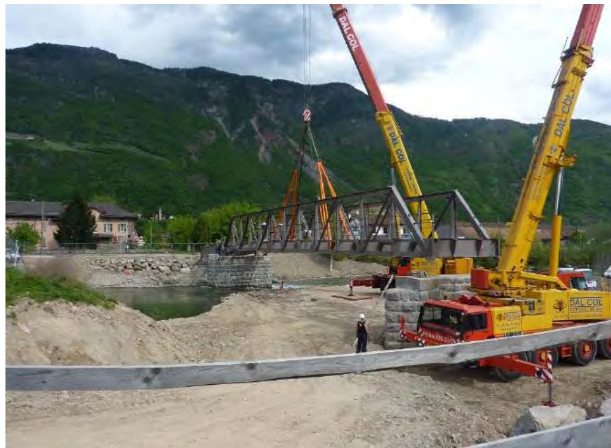
1908 E-Lok Lana Burgstall, Verlegung und Sanierung Eisenfachwerkbrücke über die Etsch
