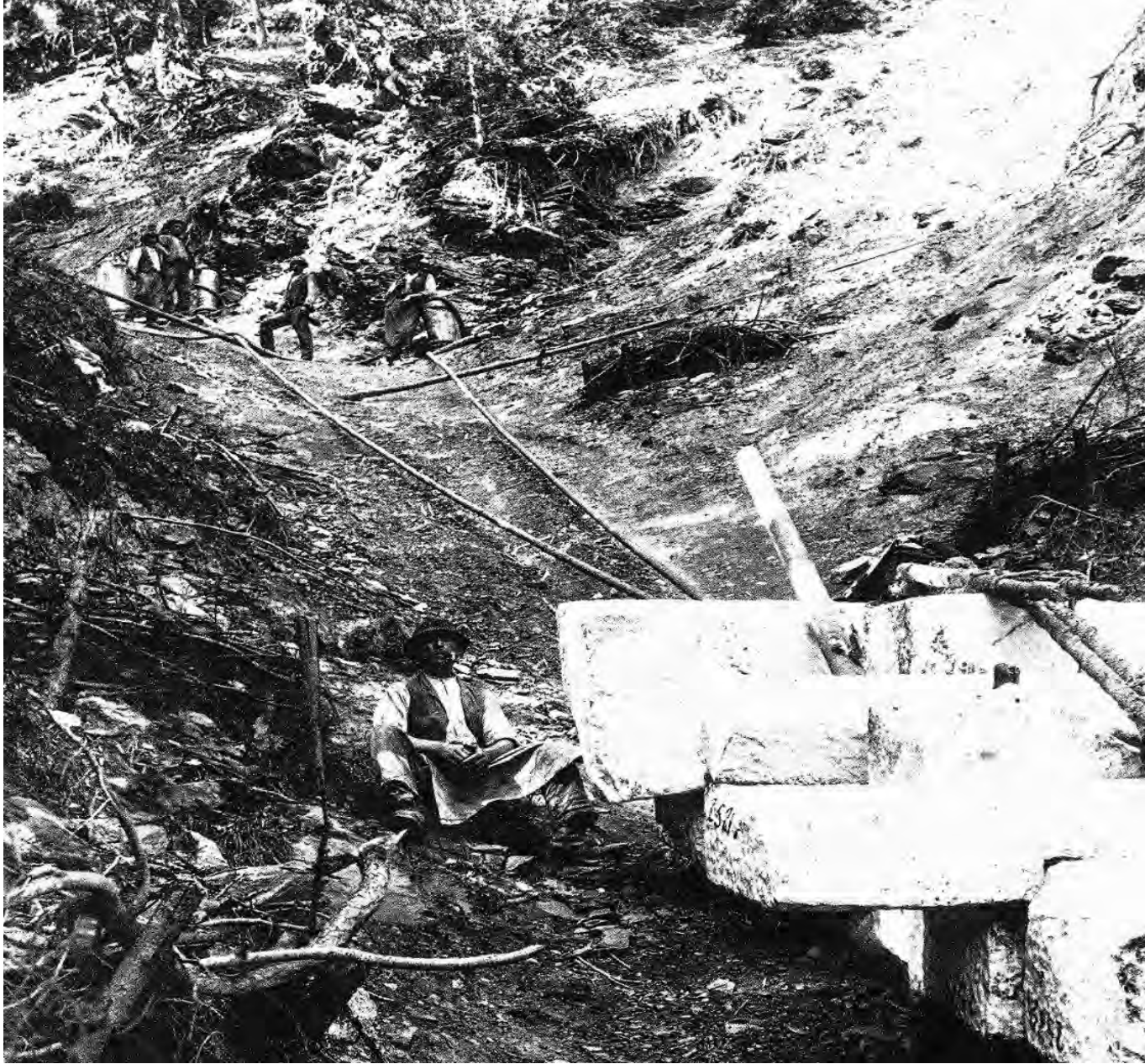
Marmorabtransport in Laas, längster Bremsberg Europas, vor dem Bau der Schrägbahn 1929
