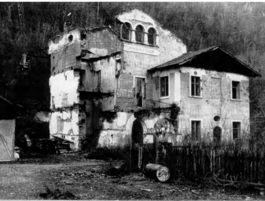
die (vom) Krieg zerstörte Station im
