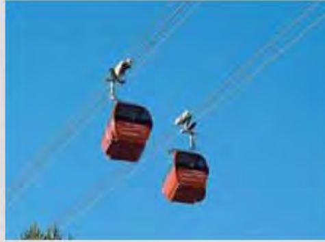
Kuppelbare Zweiseil-Umlaufbahn (BGD) La Massana, Andorra (AD)
