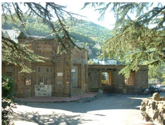
Stazione di monte - Esterno
