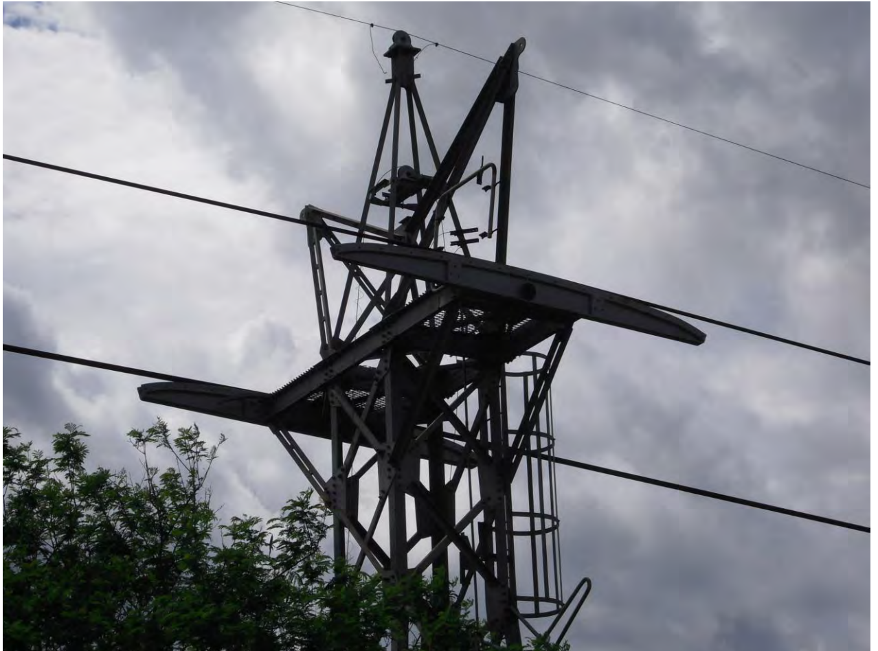
Sostegno di una teleferica con tradizionali scarpe oscillanti
