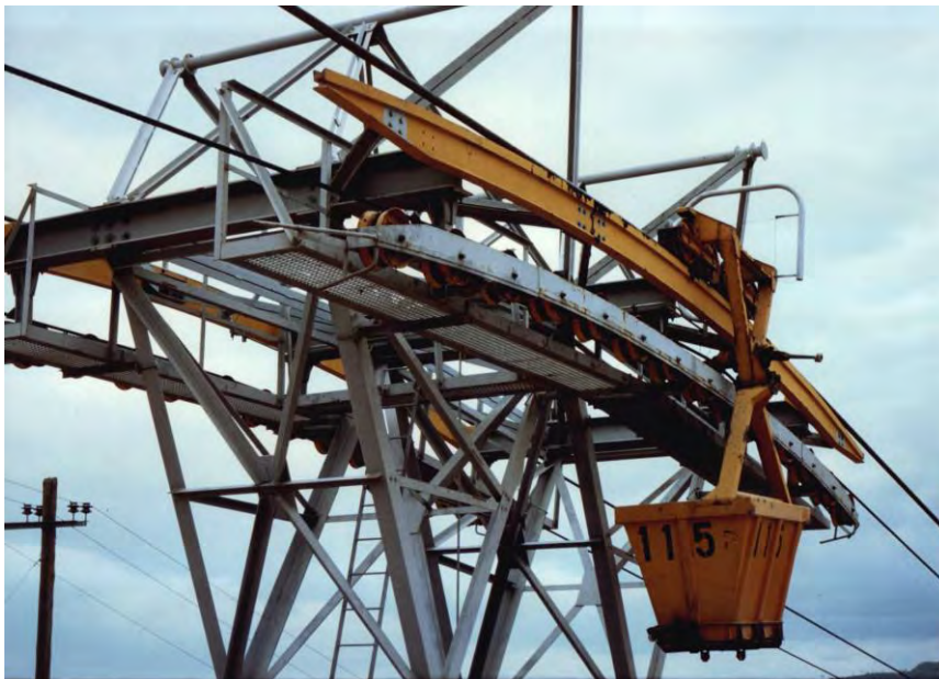
Sostegno di Rio Branco con scarpa fissa e rulliera di tipo “alto”
