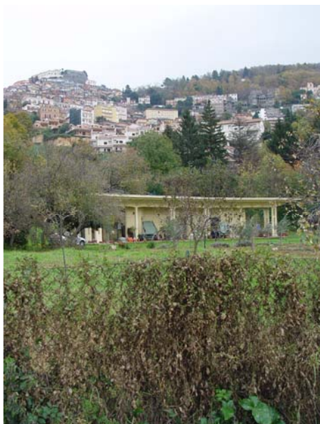
Stazione di valle –
