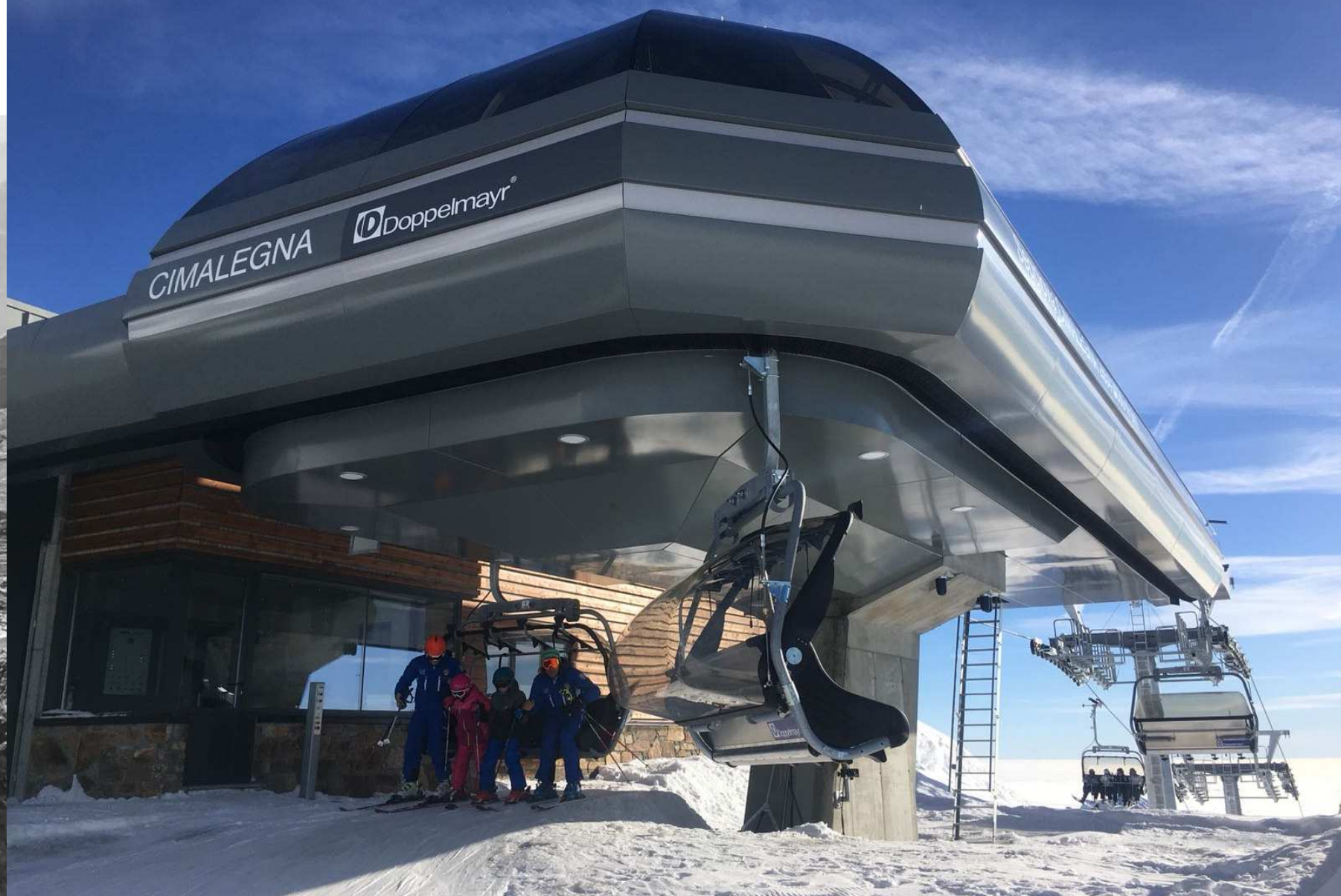
Vista panoramica Stazione Monte Seggiovvia Cimaiegna
