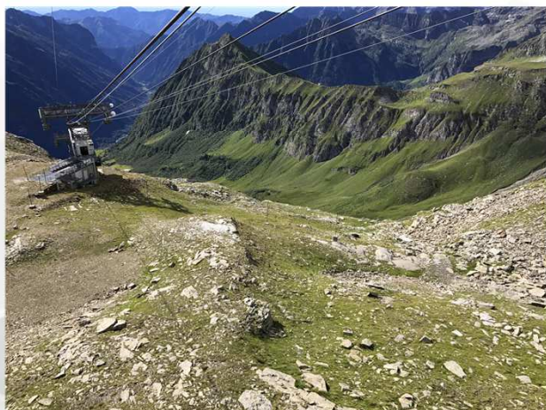
Avanzamento cantiere stazione valle
