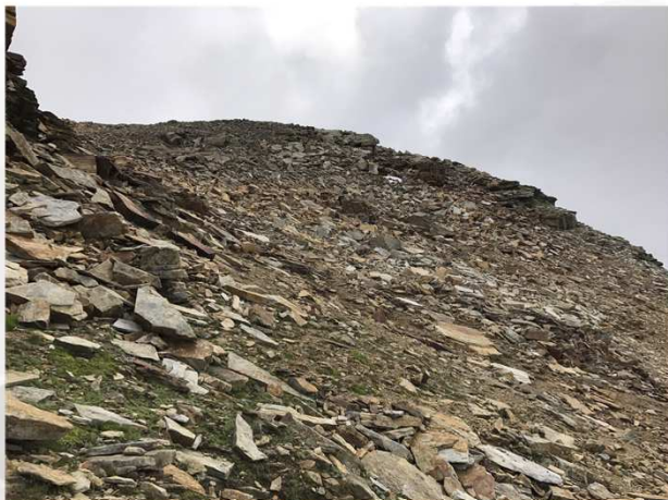
Avanzamento cantiere stazione monte
