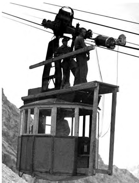
Abbildung 2: Auf Erregung mit Gleichstrom beruhende Seilprüfung an einer alten Pendelbahn von Bleichert, Zugspitze, 1950er Jahre.
