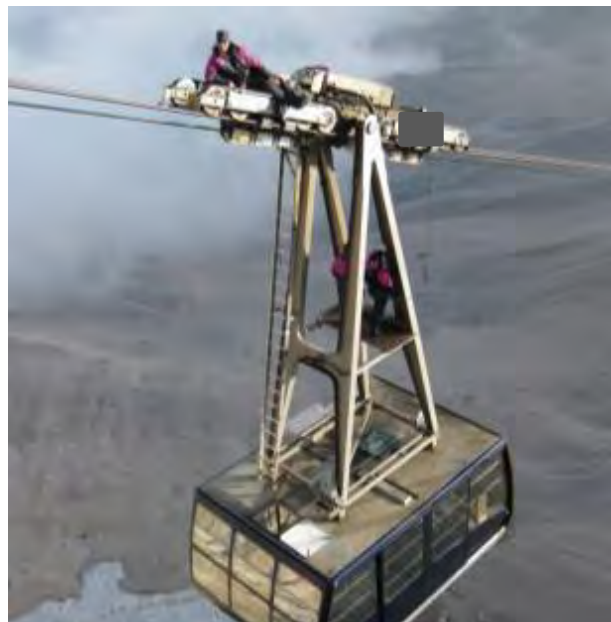
Abbildung 3.9: Visuelle Inspektion von Tragseilen auf einer Plattform und dem Laufwerk
