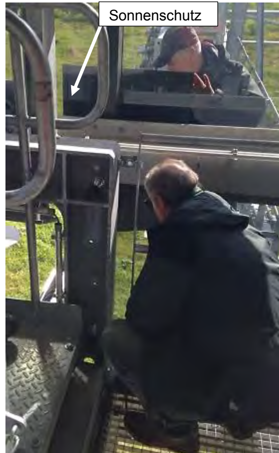
Abbildung 5.24: Anbringung des Sonnenschutzes
