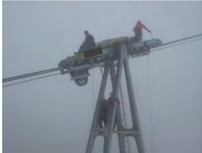
Abbildung 3.3: Nebel bei Tragseilinspektion
