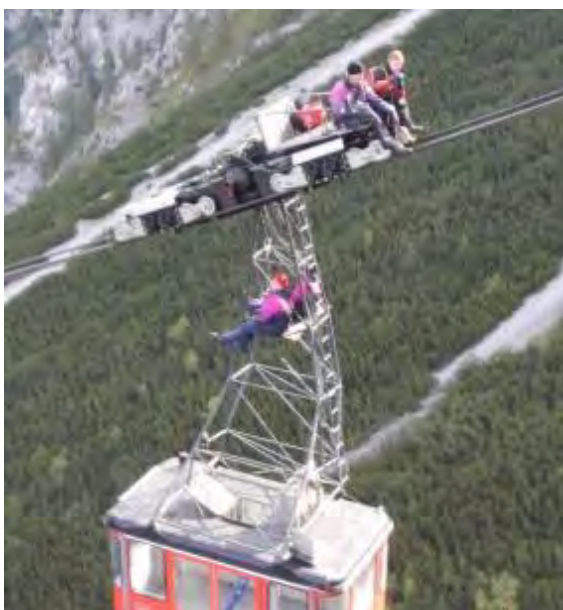
Abbildung 3.10: Visuelle Inspektion von Tragseilen mit Vorrichtung zum Sitzen und Liegen
