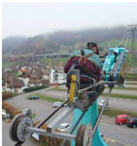
Abbildung 3.11: Visuelle Inspektion von Tragseilen mit Vorrichtung zum Sitzen
