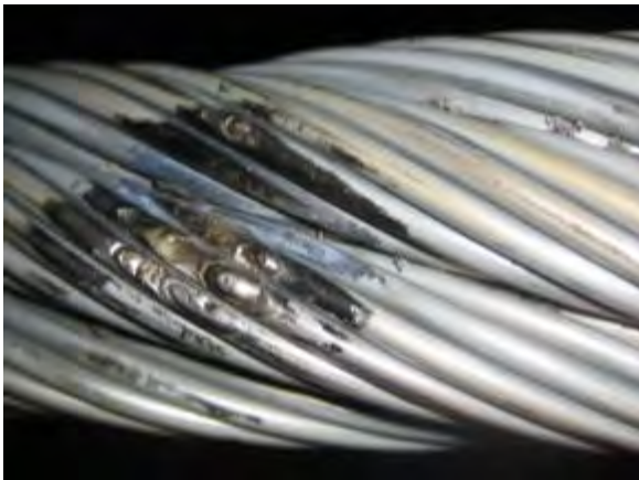
Abbildung 2.10: Blitzschaden an Litzenseil
