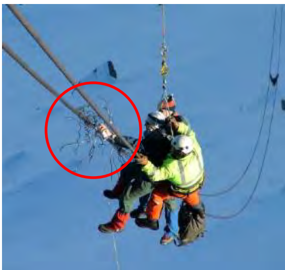
Abbildung 2.8: Tragseilschaden [6]
