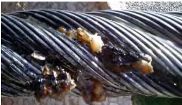
Abbildung 2.12: Blitzschaden mit großer Beschädigung an Litzenseil
