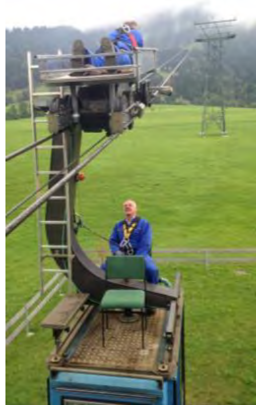
Abbildung 5.28: Visuelle Inspektion von Tragseilen an der Grüntenseilbahn
