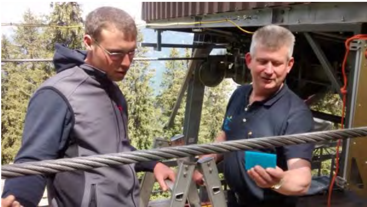
Abbildung 5.22: Inspektion mit Handspiegel
