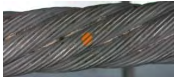
Abbildung 4.24: Korrosion 0,5 x Litzendurchmesser
