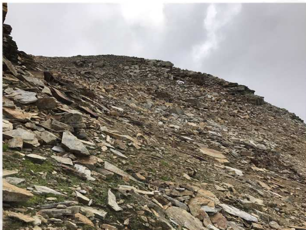
Avanzamento cantiere stazione monte
