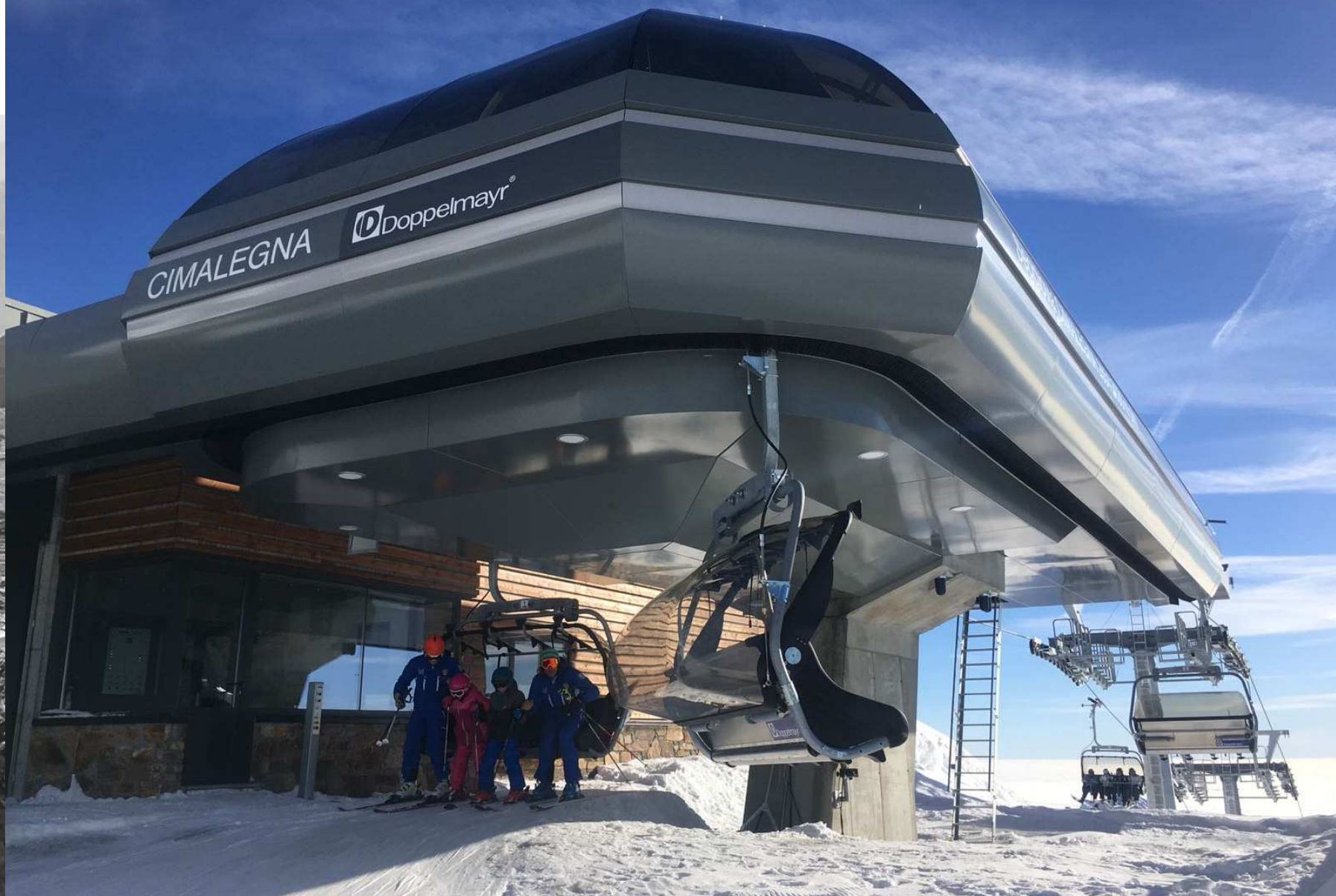
Vista panoramica Stazione Monte Seggiovia Cimaiegna
