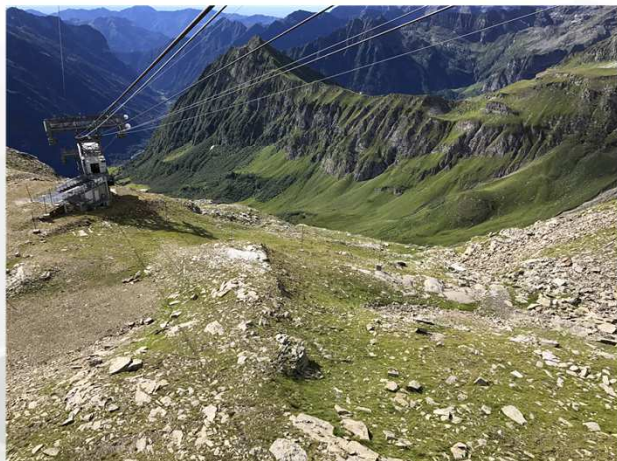
Avanzamento cantiere stazione valle
