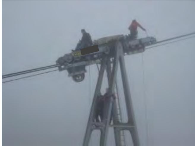
*Figura 0.3: Esame visivo di una fune portante effettuato in condizioni di nebbia*
