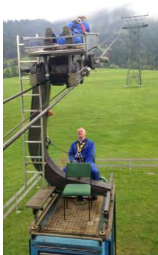
Figura 4.25: Esame visivo delle funi portanti presso la stazione di Grünten
