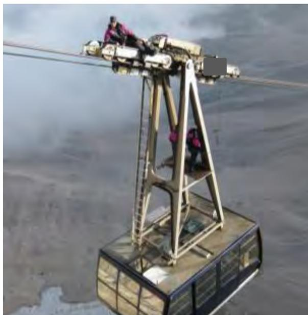
*Figura 0.9: Ispezione visiva della fune portante su piattaforma e carrello*
