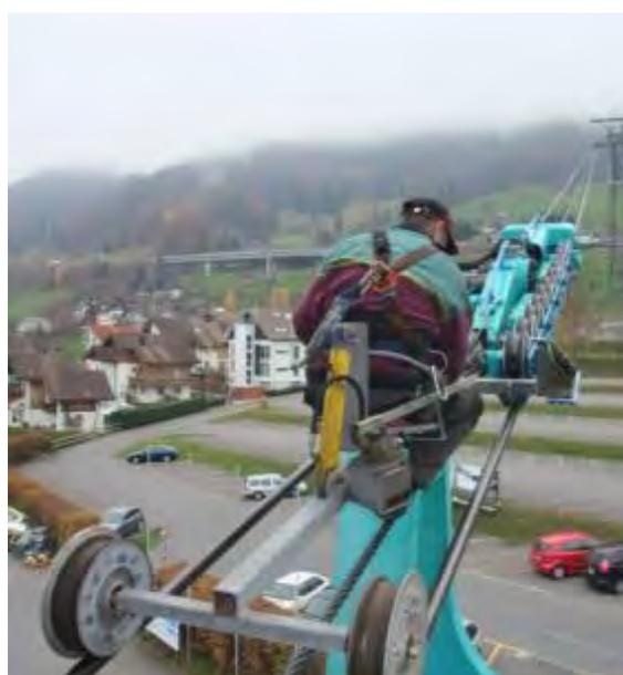
*Figura 0.11: Ispezione visiva della fune portante con dispositivo per ispezione in posizione seduta*
