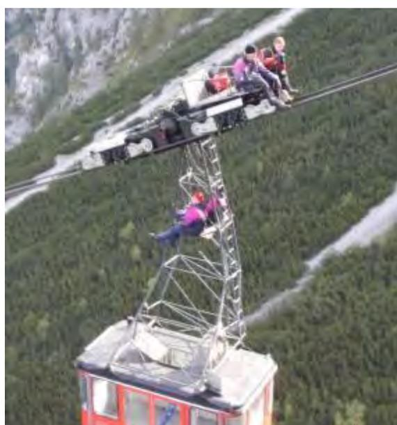
*Figura 0.10: Ispezione visiva di una fune portante con dispositivo per ispezioni in posizione seduta o sdraiata*
