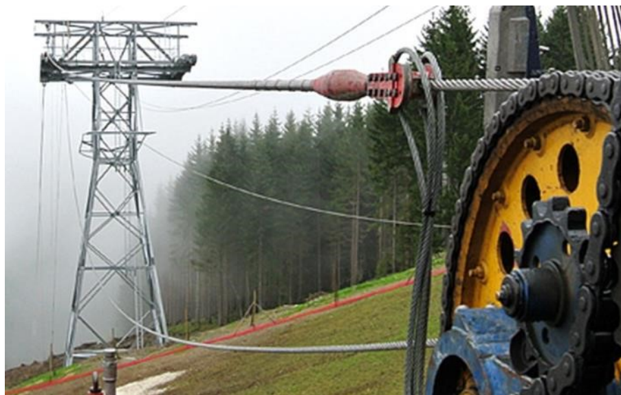
Abbildung 3: Letzte Stufe des Seilzugs einer Pendelbahn (Quelle: g-link.at)
