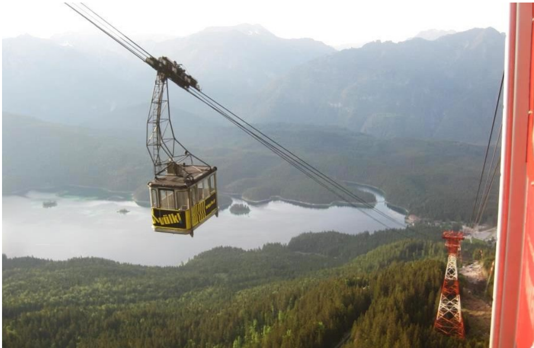
Abbildung 1: Eibseebahn von Grainau zur Zugspitze (Länge: 4500 m / Höhenunterschied: 2000 m)
