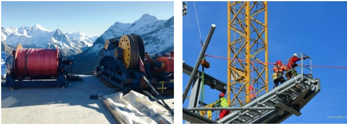
Abbildung 5: Pilotseilzug mit neuem hochfesten Dyneema-Seil (Quelle: espazium.ch / blog.i-g.ch)
