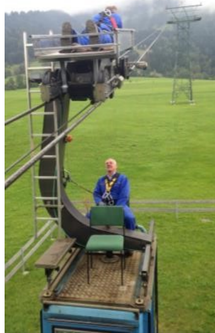
Abbildung 21: Sichere Durchführung der visuellen Inspektion von Tragseilen
