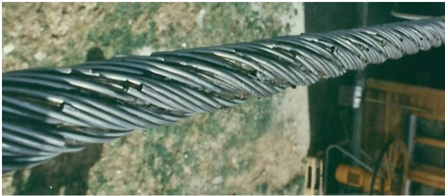
Abbildung 2: Folgeschäden von gerutschter Klemmplatte
