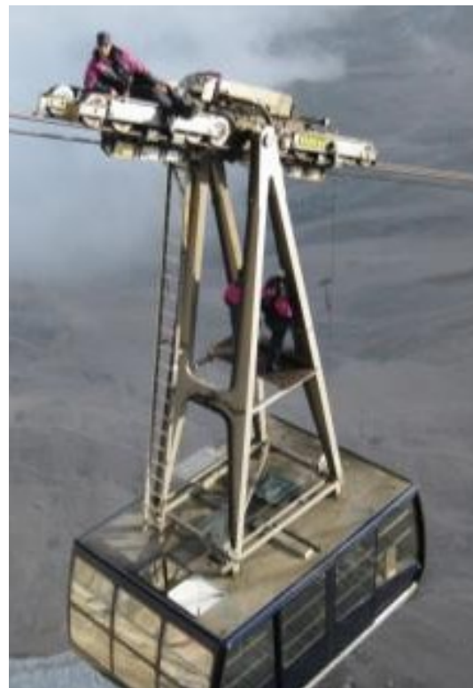
Abbildung 8: Visuelle Inspektion von Tragseilen auf einer Plattform und dem Laufwerk
