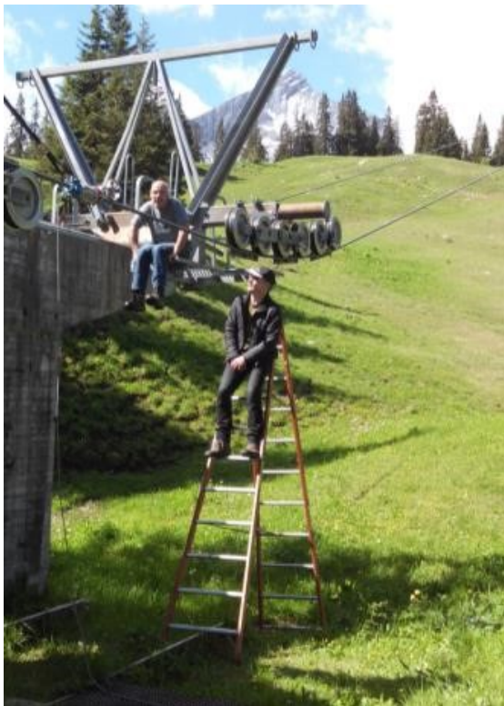
Abbildung 7: Visuelle Inspektion auf einer Leiter und einer kleinen Plattform
