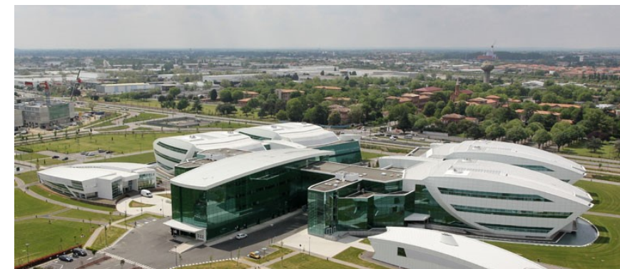
Laboratoires Pierre Fabre Toulouse Oncopole / Pierre Fabre Laboratories Oncopole Toulouse
