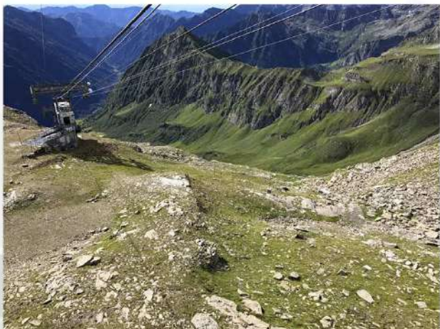
Avanzamento cantiere stazione valle
