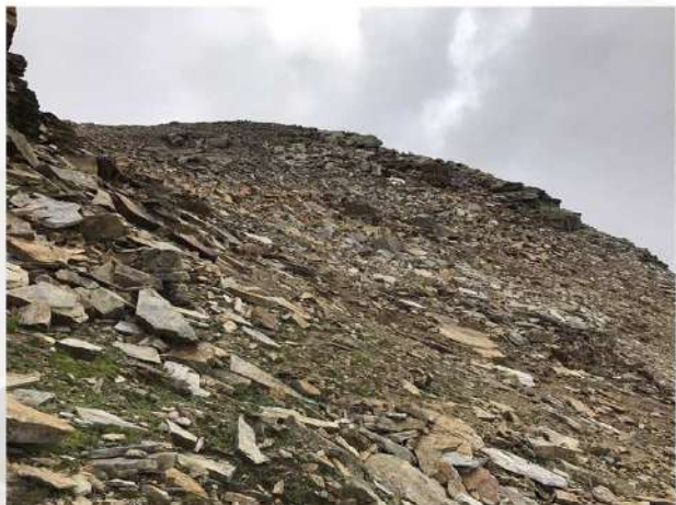
Avanzamento cantiere stazione monte
