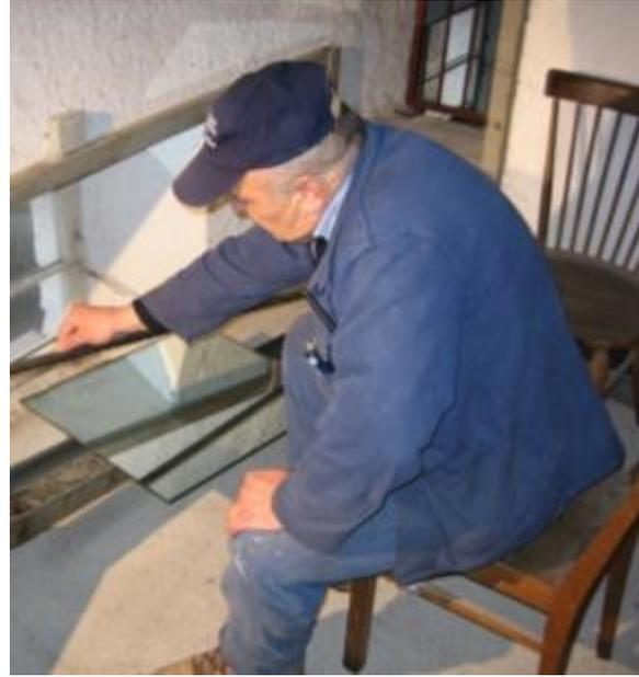
*Abbildung 6: Inspektion mit einer Person plus Spiegel*
