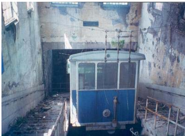
Stazione di monte - Vettura
