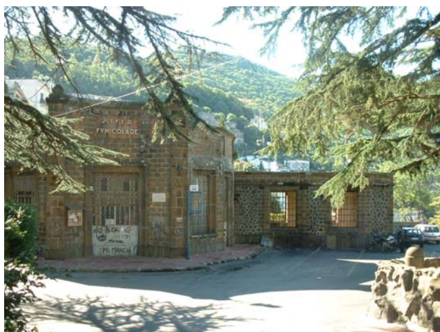
Stazione di monte - Esterno
