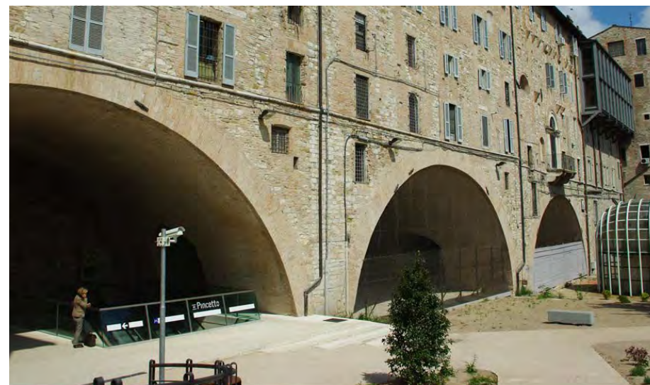
Risalita al Pincetto con scale mobili ed ascensore inclinato
